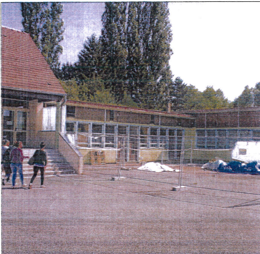
Les bâtiments préfabriqués du lycée rural sont en cours de démolition
